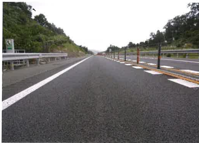
舗装補修後イメージ
