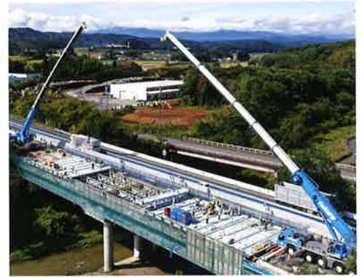
工事実施状況
