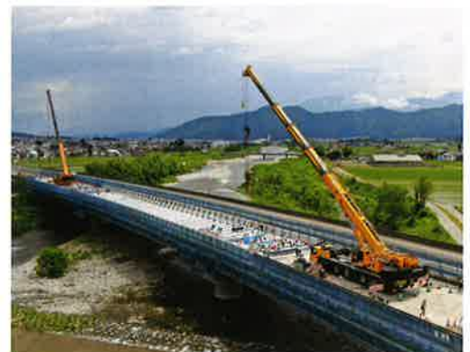
工事実施状況(イメージ)
