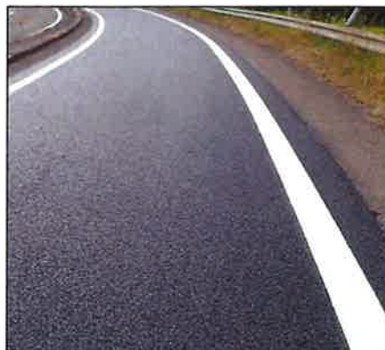
舗装補修完了状況(イメージ)
