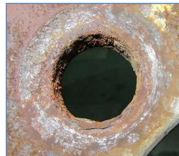
著しいさびによる ディスク・ホイールの損傷
