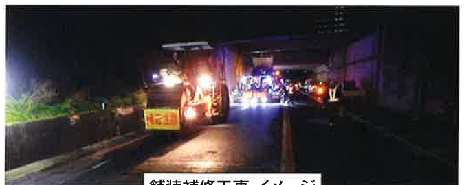
舗装補修工事 イメージ
