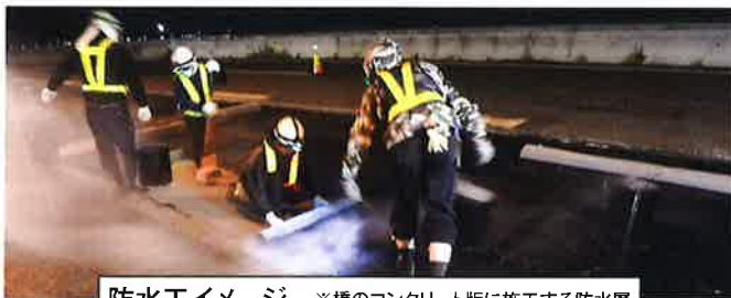
防水工イメージ ※橋のコンクリート版に施工する防水層
