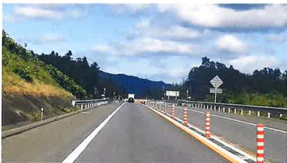
ワイヤロープ式車線区分柵設置前
