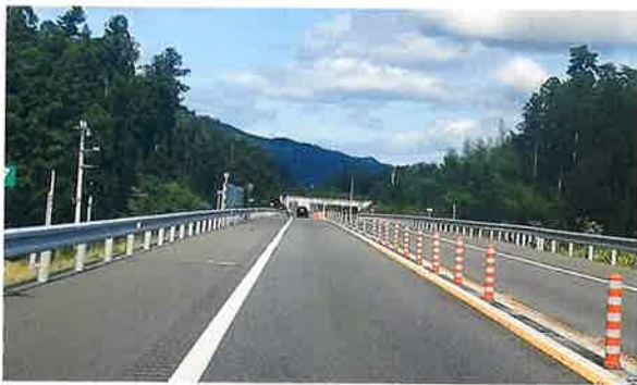
ワイヤロープ式車線区分柵設置前
