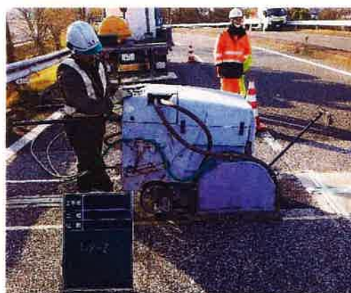
アスファルトカッターによる路面切削
