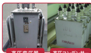
高圧変圧器 高圧コンデンサー
