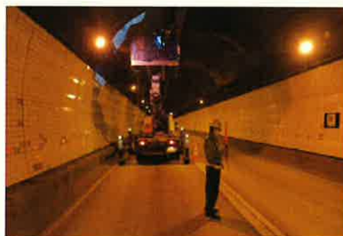
▲トンネル本体点検イメージ
